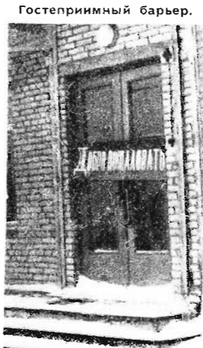
Парадный вход в комбинат бытового обслуживания «Грация». Фото А. Бондарь, г. Светлогорск.
